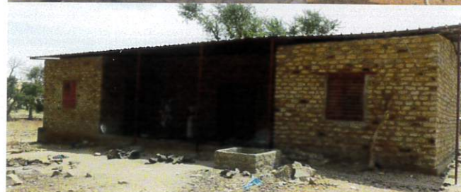
Construction d'un centre de santé (Nombori)
